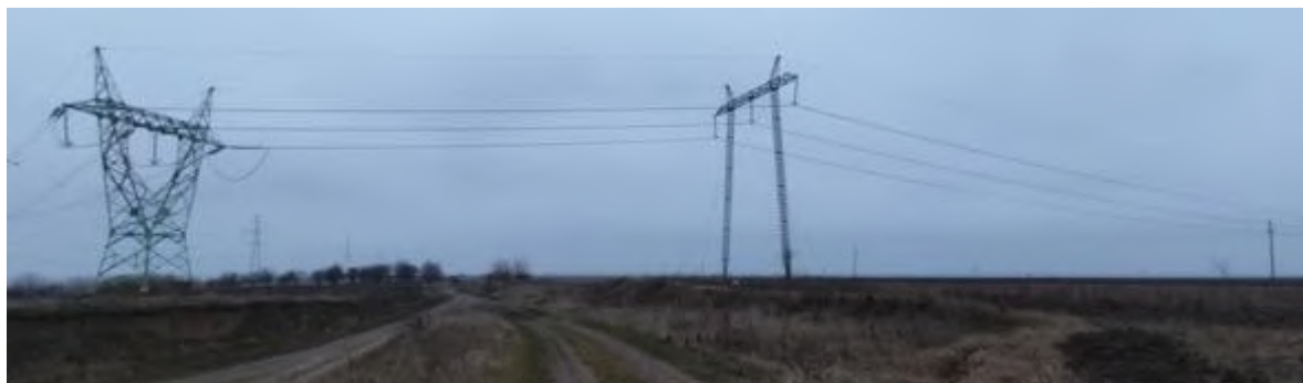
Слика 2-19 Тачка спајања далековода на западном ободу локације
