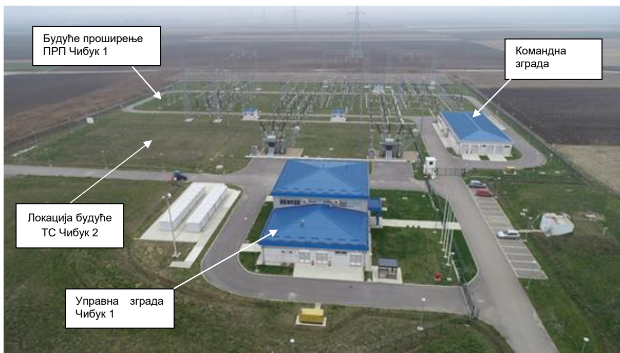
Слика 3-4 Постојећи управни комплекс ветропарка „Чибук 1“, ПРП „Чибук 1“ и локација будуће ТС „Чибук 2“
