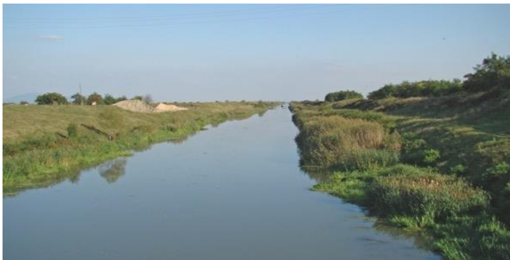
Слика 2-16 Канал ДТД пролази кроз ИБА подручје Вршачки ритови
